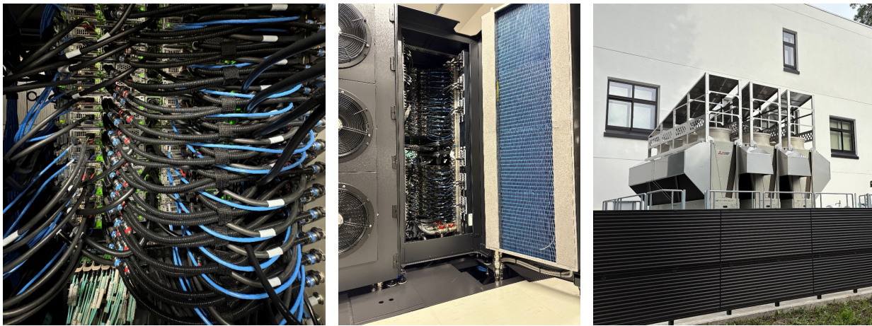
(a) CPU ノードの裏側の様子 (b) 水冷付きリアドア (CPU ノード群) (c) チラー (屋外)
