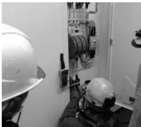
図4 保守切替盤への仮設ケーブル接続
