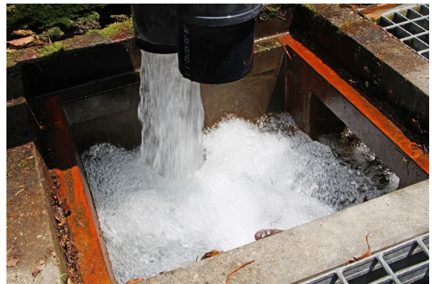
図4 排水溝に流している湧水
