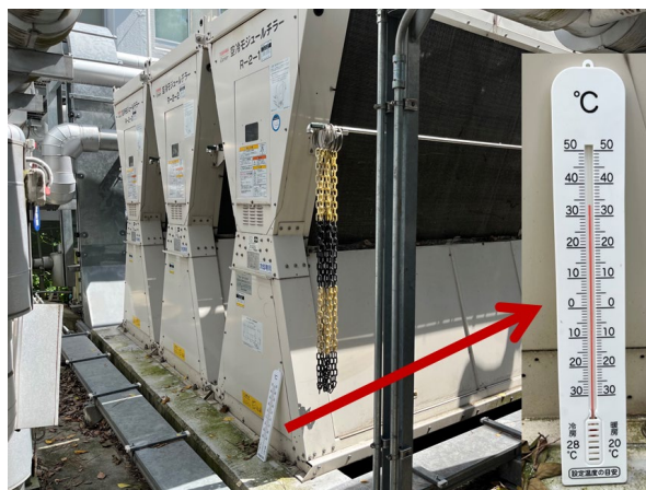
図6 寒暖計を臨時に設置した様子
