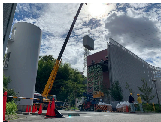
図 3 IT コア棟 キュービクルの搬入風景
